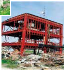
南三陸町防災対策庁舎
