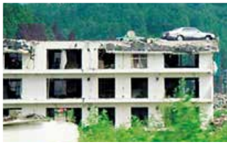
大規模な津波に見舞われた宮城県南三陸町。マンションの屋上まで自動車が行き止まりました
